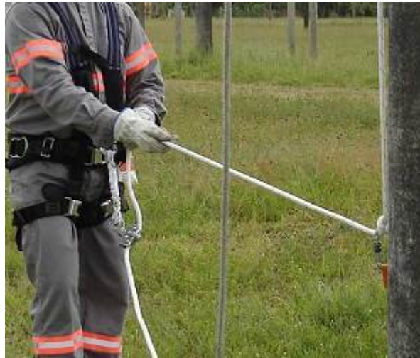
Figura 40 – Acionamento do nó de freio
