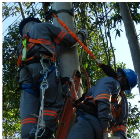
Figura 47 – Socorrista passando o talabarte de posicionamento
