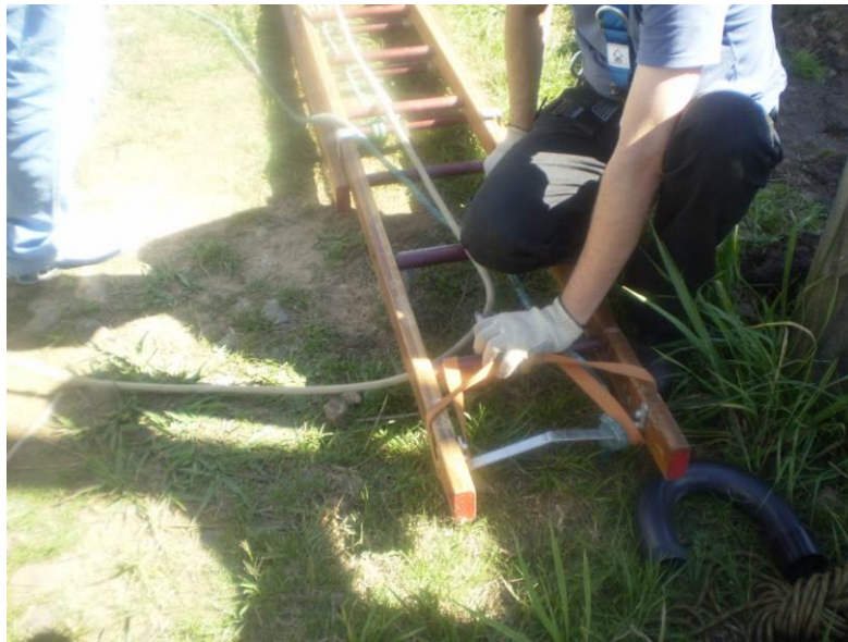
Figura 13 – Instalação da linha de vida
