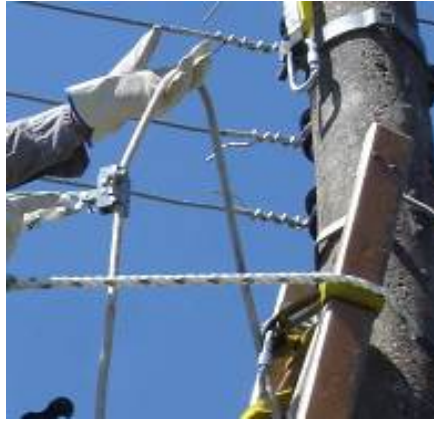
Figura 19 - Transposição da linha de vida para novo ponto de ancoragem
